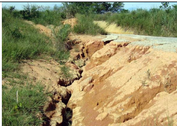
Foto V.4.2.4 – 27 - Ravinas de erosão em aterro para construção de estrada dentro do TECAB
