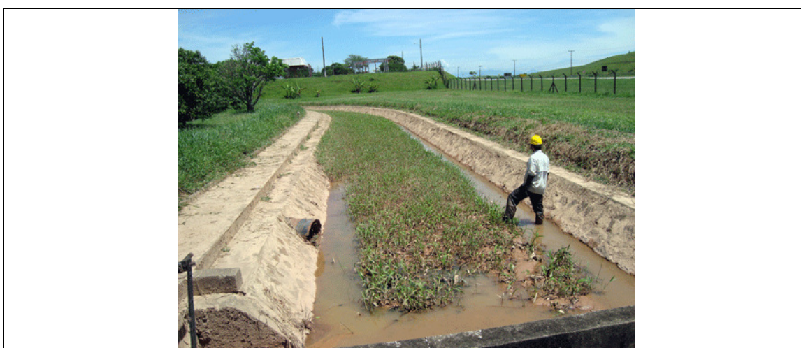
Foto V.4.2.4 – 26 - Canal da estação amostral TECAB (Ponto I02), representando os tipos de impacto aos quais já estão sujeitas as estações amostrais estudadas: retificação do canal, canalização, assoreamento, supressão de vegetação ripária e impermeabilização dos bancos laterais.
